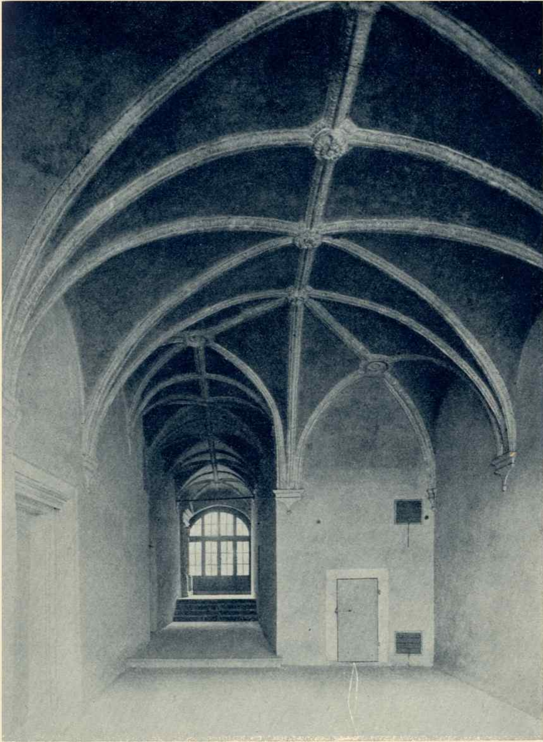
Вестибюль дома Собѣскаго.
